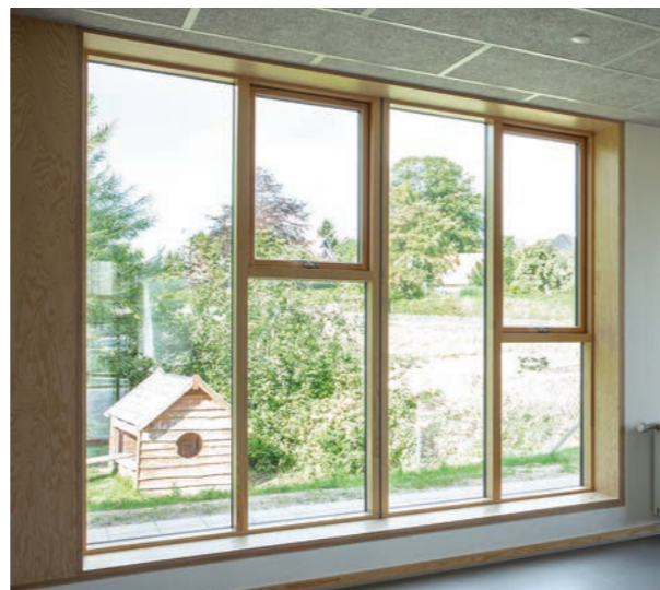
VINDUER INDVENDIGT SAMT LYSNINGER OG BUNDPLADER UDFØRES I FYRTRÆ FOR AT GIVE VARME TIL RUMMENE ▶
